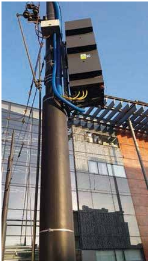
Fot. 1-2. Słup trakcji tramwajowej z zainstalowaną na nim przetwornicą do ładowania zasobnika.
