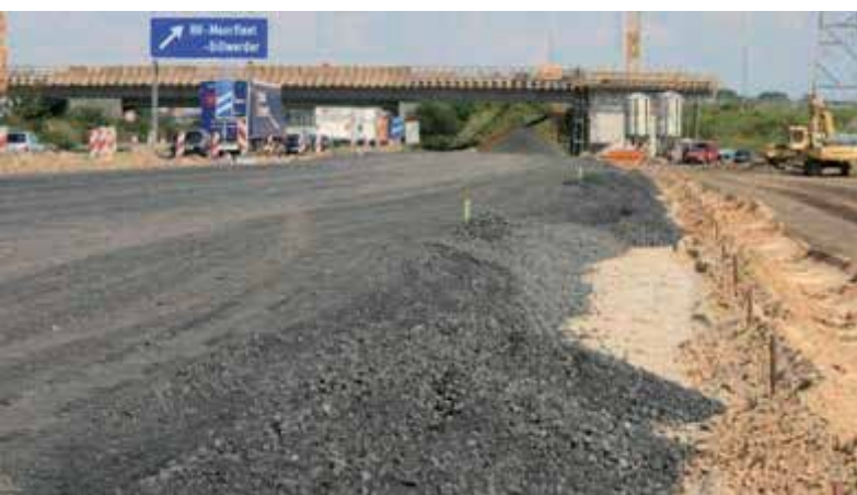
Fot. 3. Podbudowa drogi z kruszywa żelazowo-krzemowego (Hamburg).
