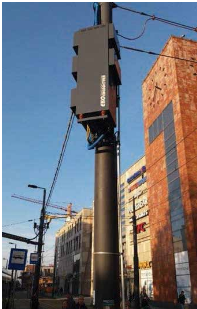
Fot. 3. Połączenie pomiędzy słupami trakcji tramwajowej przewodów do ładowania autobusów elektrycznych: na pierwszym planie przetwornica statyczna, w głębi w ramię wysięgnika z przyłączem do ładowania.
