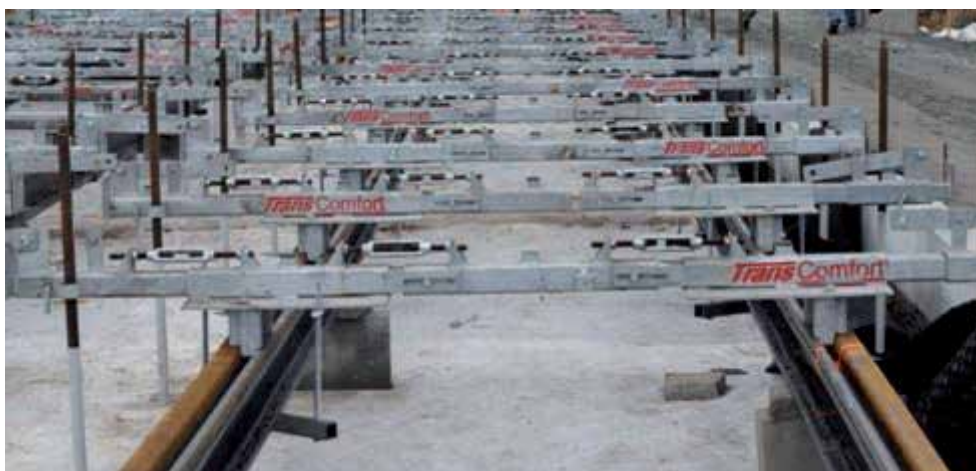
Fot. 1. Szyny w profilach elastomerowych systemu RCS podwieszone na bramkach montażowych.
